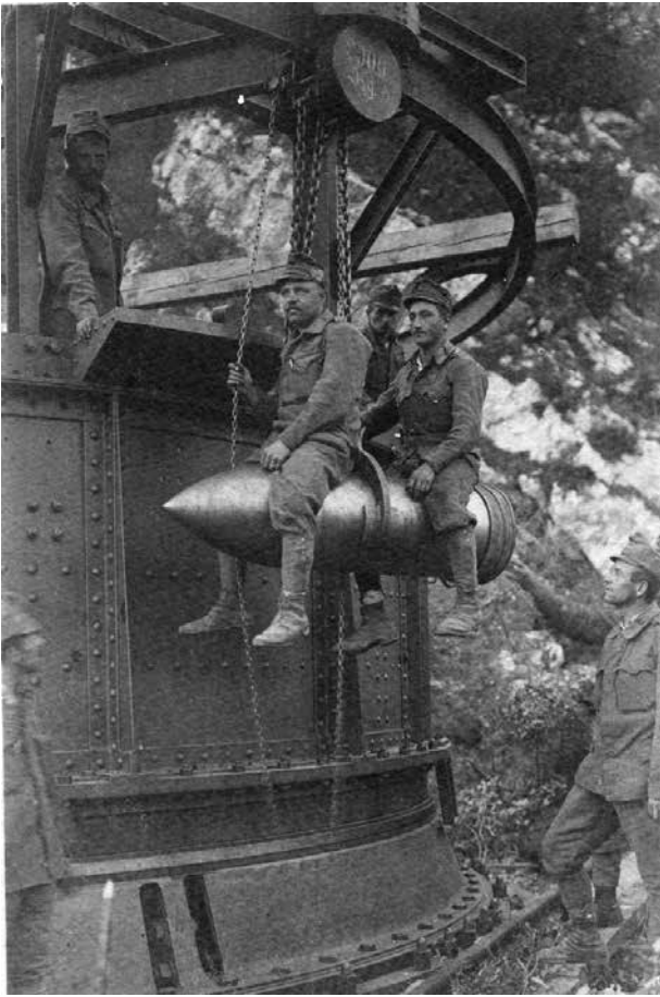
Val di Riva, Rovereto, Cannone Skoda da 420 detto la Berta. Paranco caricameno proiettile
