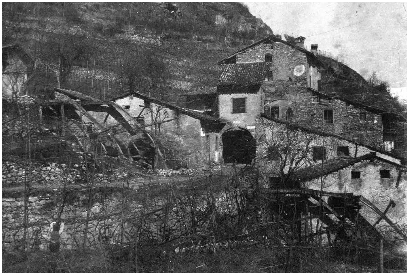
I Castelletti dei Molini di Nogaredo: doccioni di adduzione acqua e ruote
