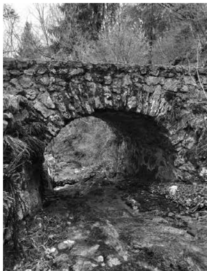
Foto 3) Ponte romano sopra il Rio Cavazzino; vicino ai ruderi del mulino
