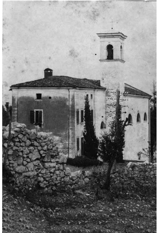
Chiesa cimiteriale di S. Lucia di Nogaredo. Campanile del 1634
