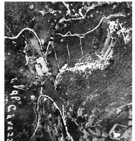
Foto 5) (aerea): mulino nel 1918, ancora integro, con strade e campetti adiacenti
