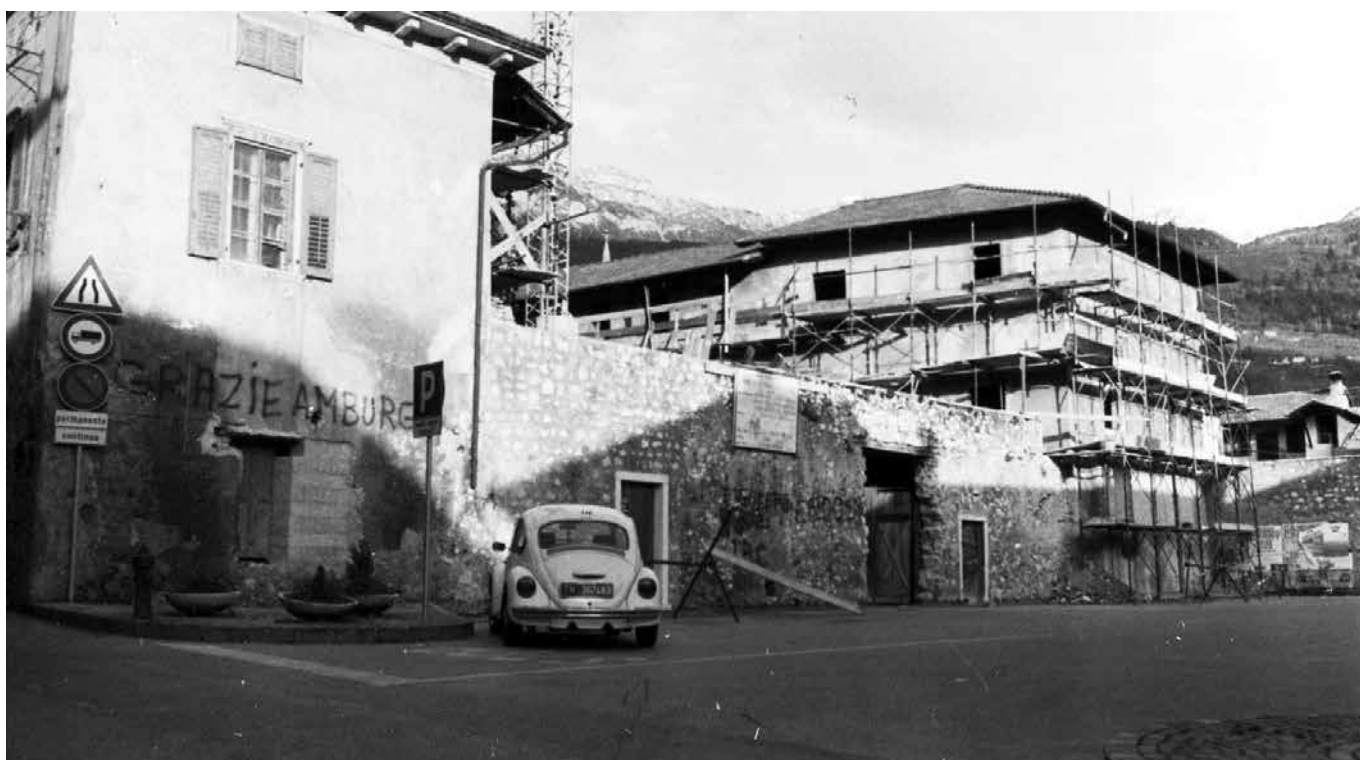
Villa Lagarina anni '80, casa Scrinzi in ristrutturazione per realizzare il nuovo comune – da notare il "maggiolone" di Francesco Leoni della ditta appaltatrice ▼
