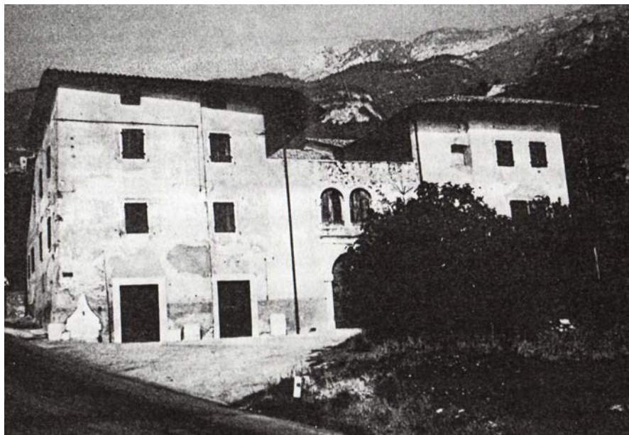
Filatoio di Nogaredo al Cornaledo
