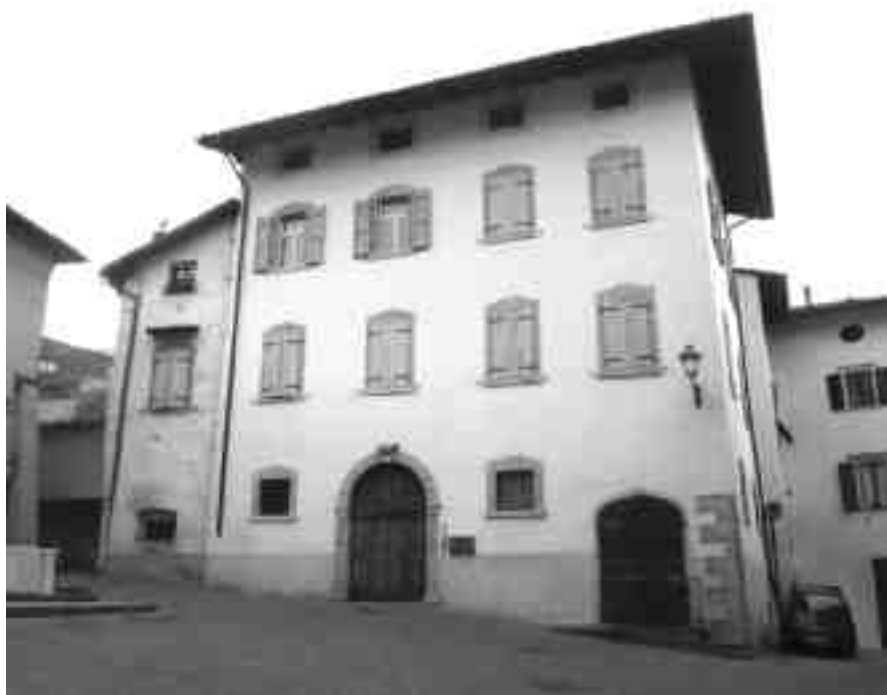
Facciata di casa Marzani prospettante su piazza Battisti, già del Pionte
