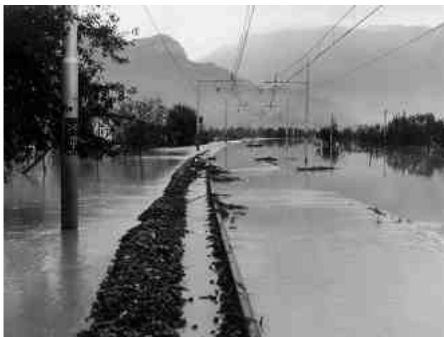
La ferrovia del Brennero, allagata a monte della stazione di Villa Lagarina, novembre 1966 (fonte privata, S. Giordani)
