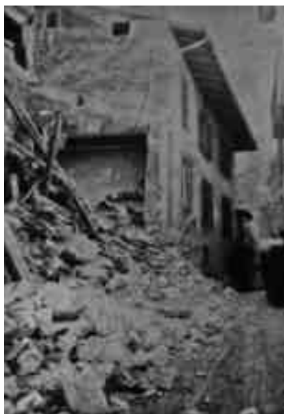
Casa Benvenuti distrutta da bomba italiana
