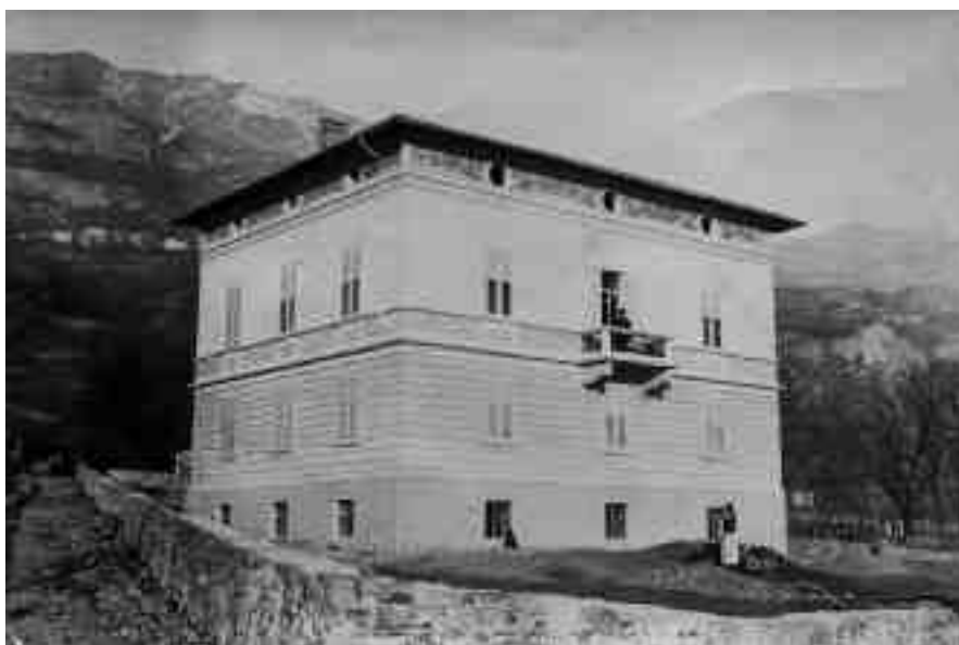
La "villa" appena terminata, con l'ampia scalinata d'accesso ancora da costruire
