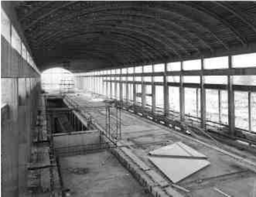
Capannone locale macchine
