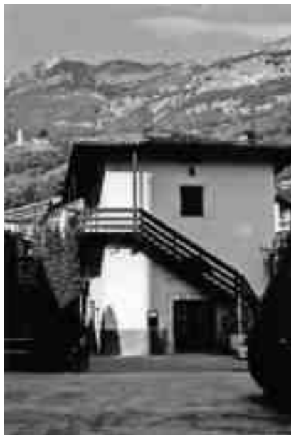
L'Ossario secentesco eretto nell'angolo nord - ovest del cimitero di Villa. Tale cimitero fu in funzione dalla fondazione della Pieve fino al colera del 1836. Attualmente l'edificio dell'antico Ossario è sede del Gruppo Anziani e Pensionati di Villa Lagarina. Sul pavimento del bar si conservano le cornici lapidee delle antiche lastre tombali (foto I. Prosser 2009)
