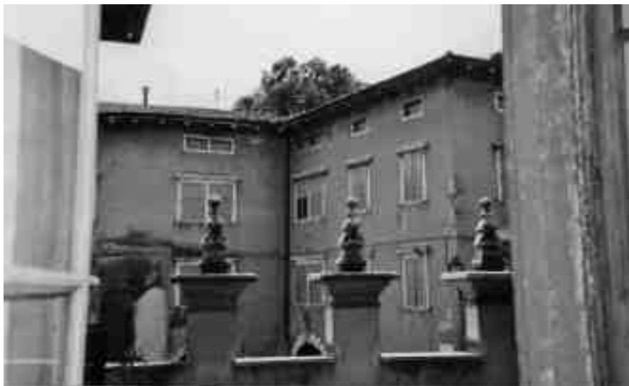
Casa Marzani vista da casa Madernini, 1997
