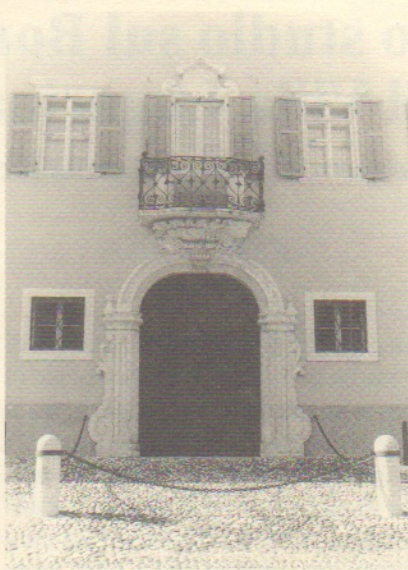
Palazzo Guerrieri-Gonzaga, particolare della facciata con il portale barocco
