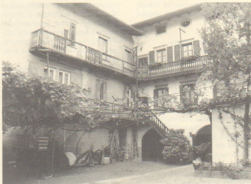
Le corti sono elementi fondamentali per la lettura del tessuto edilizio lagarino. Nell'immagine la corte interna di palazzo Madernini, oggi Zandonai
