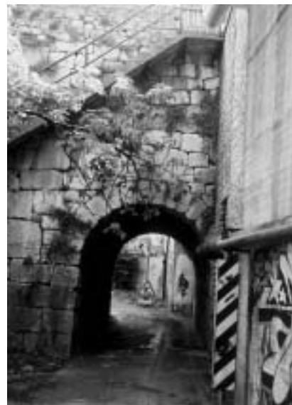
Particolare della testa sinistra (verso Rovereto) dell'antico ponte in legno. (Foto Borgoantico)
