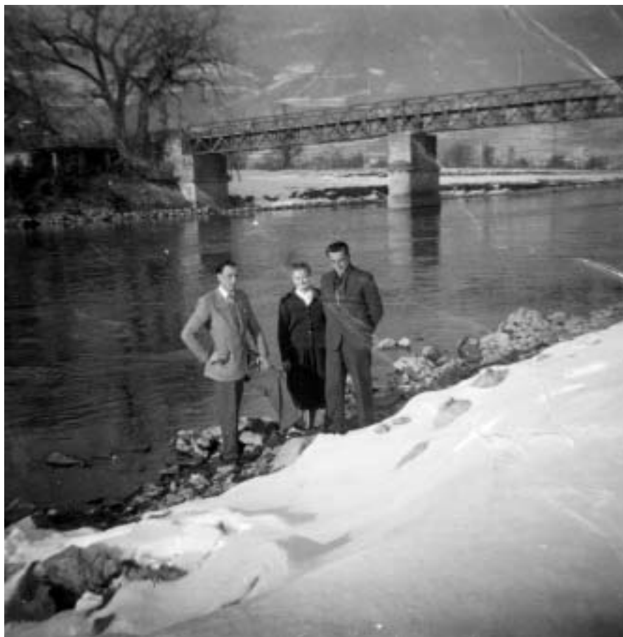
Foto ricordo sulla riva sinistra dell'Adige. Sullo sfondo il ponte in ferro. (Proprietà Rita Galvagni)
