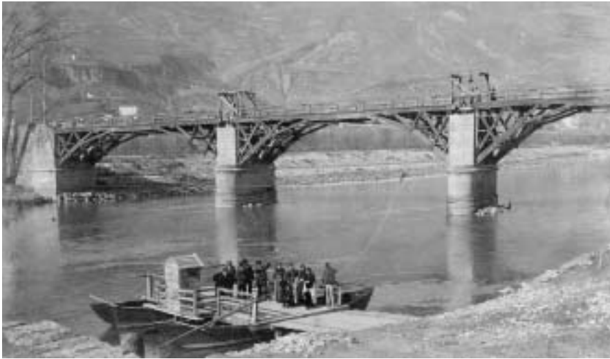
Gli ultimi anni del ponte in legno. La foto risale probabilmente al 1895. Si sta smantellando il ponte in legno e si stanno abbassando i piloni per ridurne l'altezza. Nella circostanza della costruzione del nuovo ponte viene ripristinato il servizio di traghetto. (Proprietà Franco Decarli)
