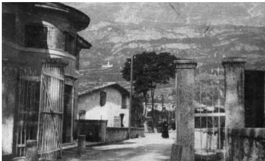
Particolare del cancello, che veniva chiuso di notte. In secondo piano parte di un edificio laterale della copèra. (Proprietà Franco Decarli)
