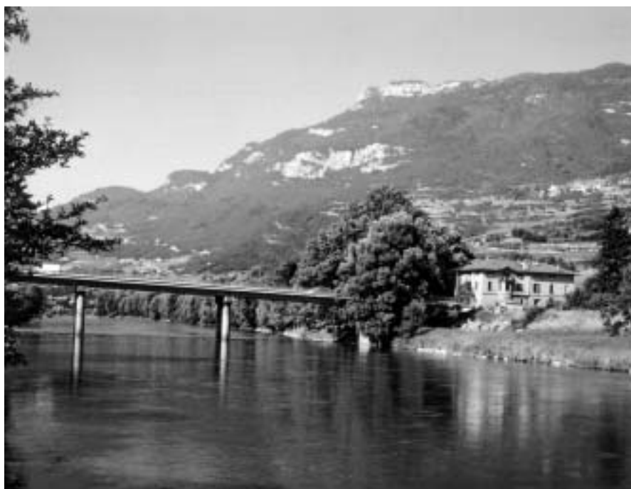
Il ponte attuale, in cemento armato, venne inaugurato il 14 agosto 1966. Nell'estate 2003 sono iniziati i nuovi lavori di ristrutturazione e consolidamento del ponte.
