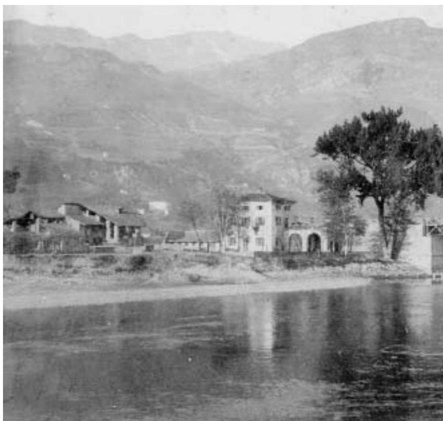
Sulla sinistra il complesso delle fornaci per laterizi ("copèra"), al centro l'Albergo al Ponte con la "mitica" terrazza, sulla destra la testa del ponte. (Si noti il posizionamento della struttura in ferro.). (Proprietà Franco Decarli)
