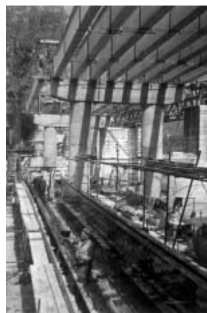
Ponte in cemento (1966) - (Fotografia originale di Enrico Riolfatti)
