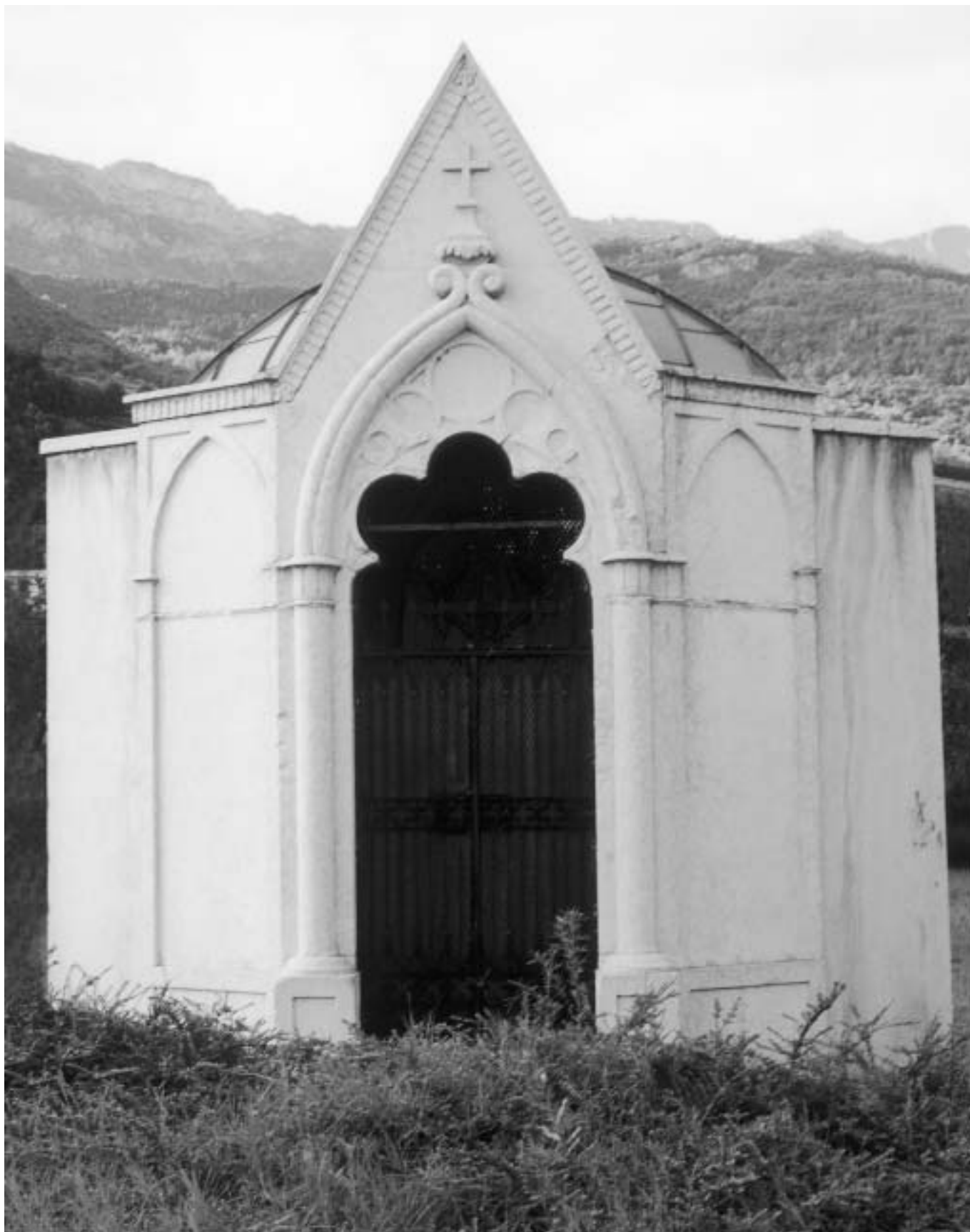
La cappella del Crocifisso costruita nel 1864 con il contributo della Delegazione del ponte dell'Adige e con l'elemosina dei privati, a ricordo della chiesetta di San Giovanni Battista al porto demolita nel 1845 (foto 2003).
